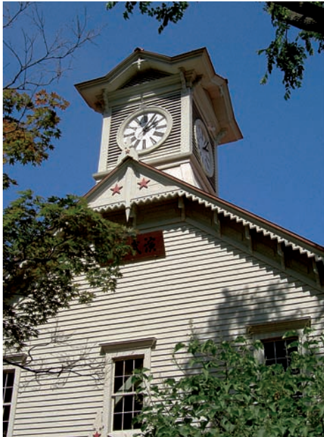
Abb. 8: Der berühmte Glockenturm von Sapporo, errichtet 1878
