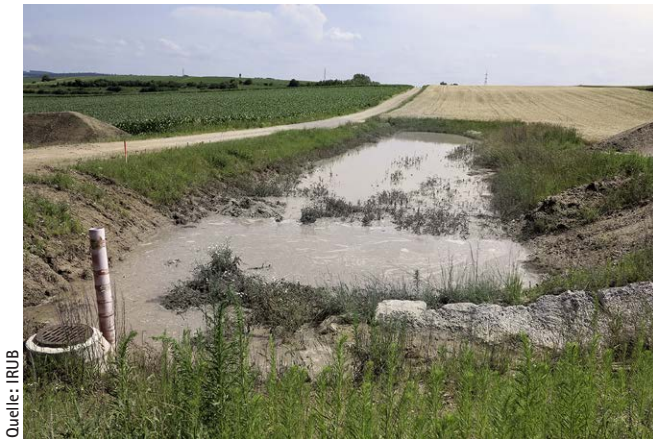
Abb. 6: Realisierung von dezentralen Wasserrückhaltebecken mittels Grundzusammenlegungsverfahren
