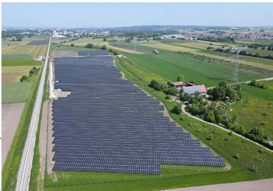
Abb. 1: Solarpark Benningen (Landkreis Unterallgäu) entlang der Bahnstrecke Ulm-Kempten auf rd. 9 ha Fläche mit 17.280 Modulen und einer Stromproduktion von rd. 10,5 GW pro Jahr, seit August 2023 auf Grundlage eines Bebauungsplans der Gemeinde Benningen in Betrieb
